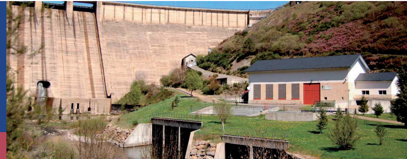
Central hidroeléctrica de Porma Porma hydroelectric generation plant
