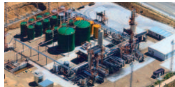
Ecolube, planta para la regeneración de aceites usados mediante el proceso patentado y desarrollado por SENER (Fuenlabrada, España). Ecolube, a plant for the regeneration of used lubricant oil with the process developed and patented by SENER (Fuenlabrada, Spain).
