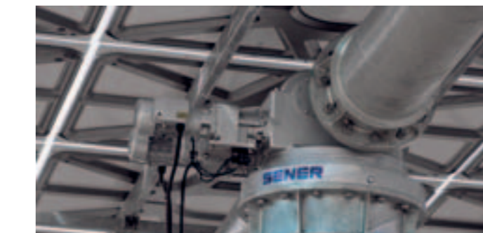
Mecanismo de actuación de dos ejes, MASS, desarrollado por SENER, y de aplicación en plantas con tecnologías CSP y CPV). MASS high performance two axes drive, developed by SENER, for CSP and HACP technologies.
