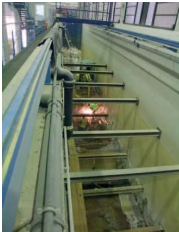
Fase inicial de ejecución del canal: excavación apuntalada.
