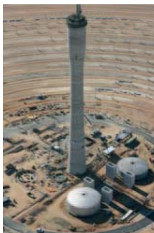
Trabajos de construcción en la planta.
